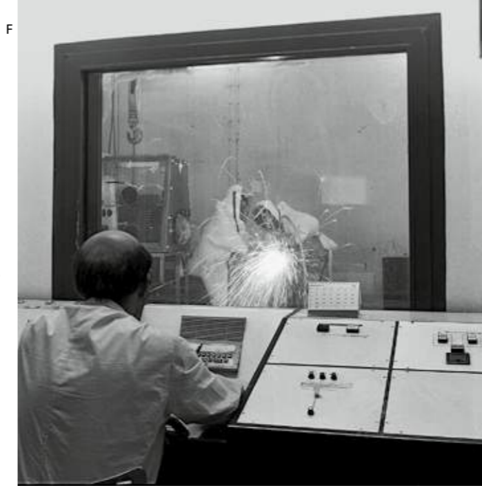
D Arbeitsplätze vor Heißen Zellen mit Bediengeräten und Manipulatoren in der Abteilung Reaktorbetrieb / Heiße Zellen, 1968 E Teststand für Interventions- und Handtungsarbeiten: Montagearbeiter im zwangsbelüfteten Strahlenschutzanzug, 1979 F Dekontamination von Gloveboxen in der Abteilung Dekontaminationsbetriebe: Unbekannte Mitarbeiter in Vollschutzanzügen beim Zerlegen der Boxen in einer abgeschirmten Zelle, 1974
