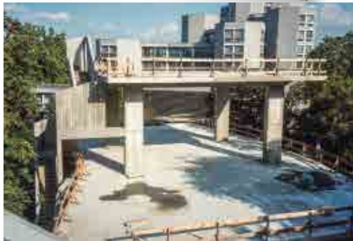
Baustelle der Ökohäuser, Berlin Tiergarten, ca. 1987
