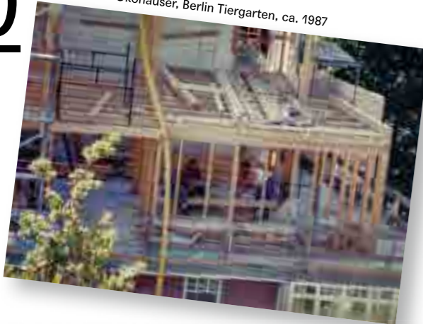
Baustelle der Ökohäuser, Berlin Tiergarten, ca. 1987
